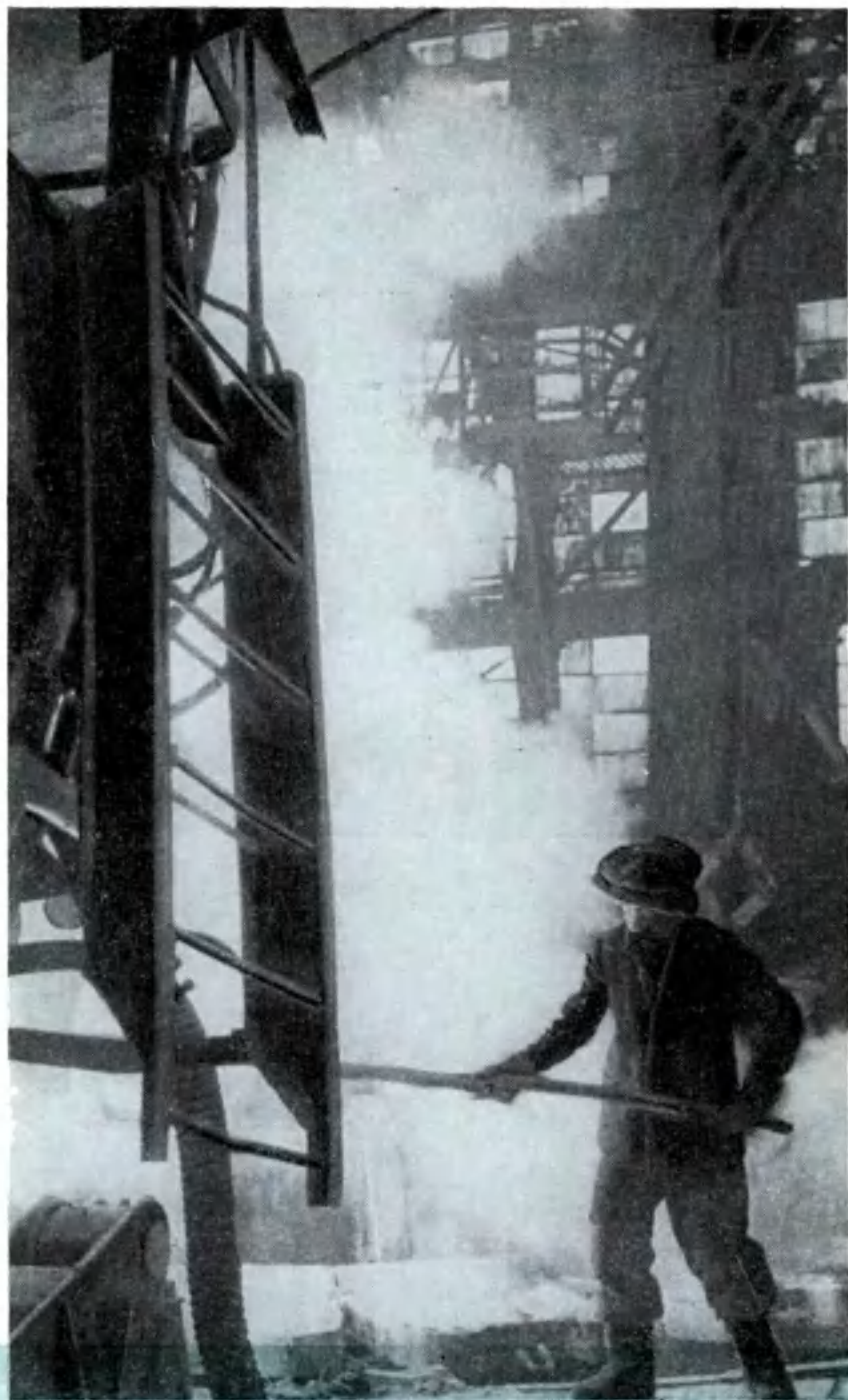
Орск. В электроплавильном цехе Южуралникелькомбината идет разлив никеля.
